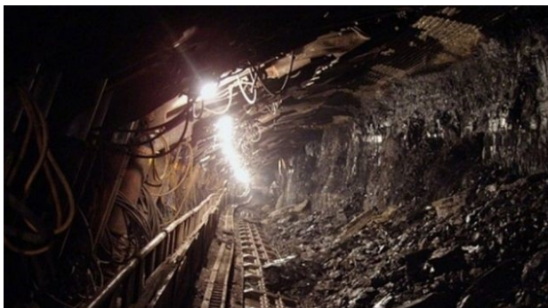
Fig. 5. Galerie de mină (Sursa: www.cronicavj.ro)
